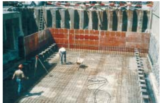
28/1 Hier mussten Bodenanker angeordnet werden, um das Abheben der Fundation von – noch zu betonierenden – duktilen Stahlbetontragwänden vom Baugrund verhindern zu können (Schweiz 1999).
