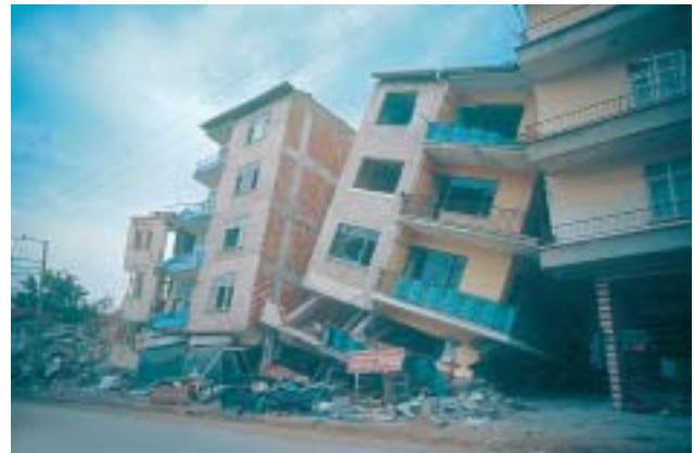
4/2 Ein Stützenmechanismus ist bei weichen Erdgeschossen oft unvermeidlich (Izmit Türkei 1999).
