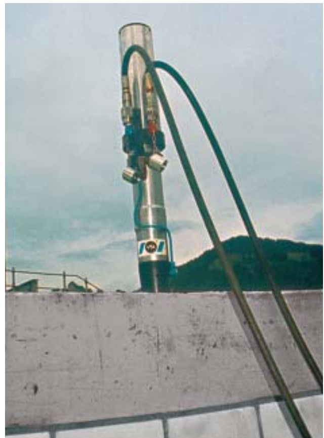
13/4 13/5 Auch eine vertikale Vorspannung kann durch die eingebrachte Normalkraft das Erdbebenverhalten von Mauerwerkswänden wesentlich verbessern (Schweiz 1996).
