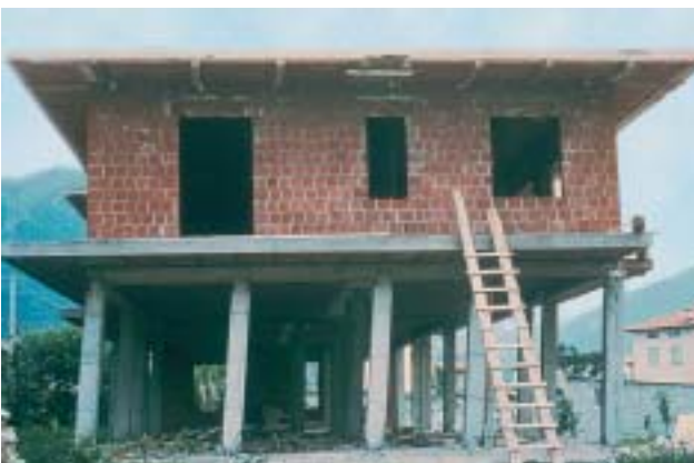
4/1 Dieser Stützenmechanismus im Erdgeschoss eines im Bau befindlichen Gebäudes führte nur ganz knapp nicht zum Einsturz (Friaul Italien 1976).
