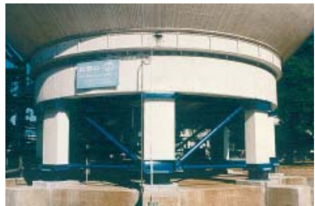
31/2 In die 8 Stahlbetonstützen wurden Erdbebenlager aus hochdämpfendem Gummi mit einem Durchmesser von 60 cm und einer Höhe von rund 30 cm eingebaut.
