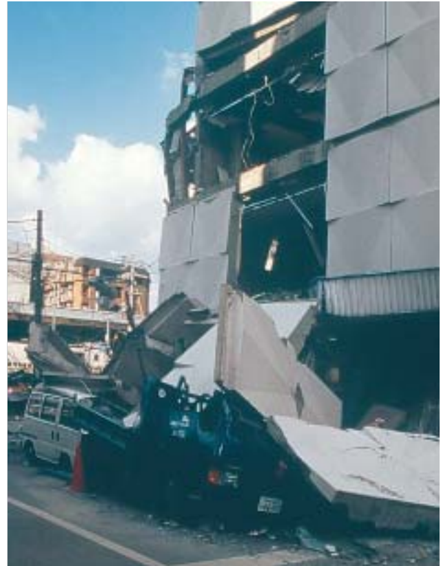
32/1 Das Tragwerk dieses Gebäudes stürzte nicht ein, hingegen sind ungenügend verankerte, schwere Fassadenplatten abgestürzt (Kobe Japan 1995).
