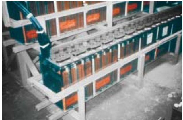
35/7 Gut gesicherte Batteriangruppen und Notstromaggregate können auch nach einem starken Erdbeben die Energieversorgung gewährleisten (Kalifornien 1980).
