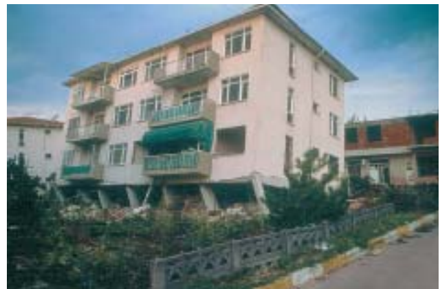
4/3 Hier stehen die vorderen Stützen – in ihrer schwächeren Richtung – schief, die hinteren haben ganz versagt (Izmit Türkei 1999).
