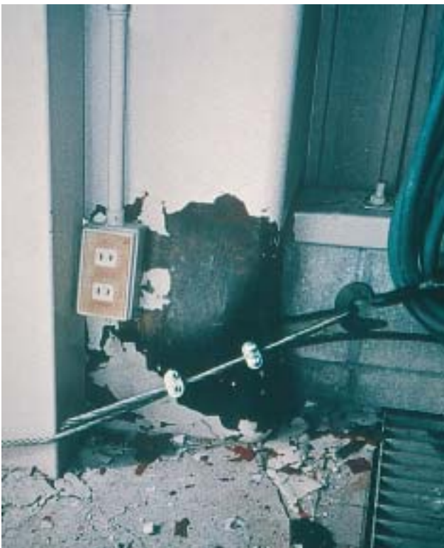
19/4 Am Fuss der Stütze eines 3-stöckigen Rahmens erfolgte ein lokales Ausbeulen des Kastenquerschnitts; dabei wurde die weisse Farbe abgesprengt (Kobe Japan 1995).
