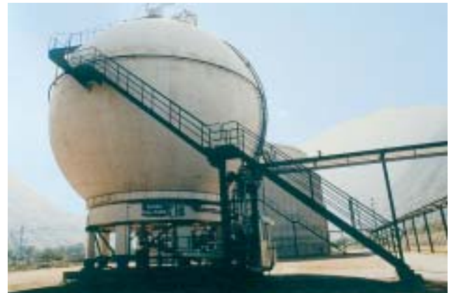
31/1 Dieser Grosstank für 700 t Flüssiggas und mit einer Tragkonstruktion aus Stahlbeton wurde durch eine «Verweichung» ertüchtigt (Schweiz 1999).
