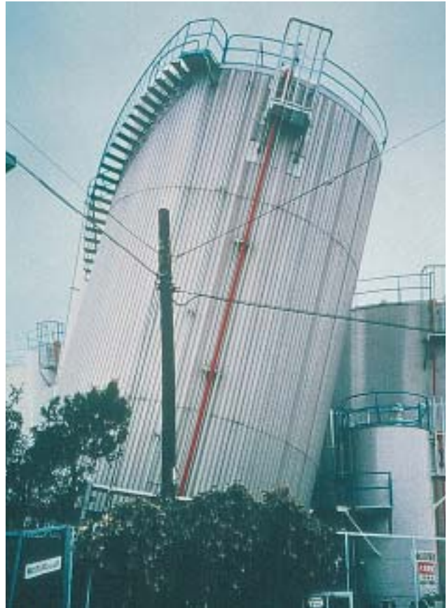
30/4 Auch dieser Tank hat sich schief gestellt. Als Ursache wurde die Verflüssigung von aufgeschüttetem sandigem Boden festgestellt (Kobe Japan 1995).
