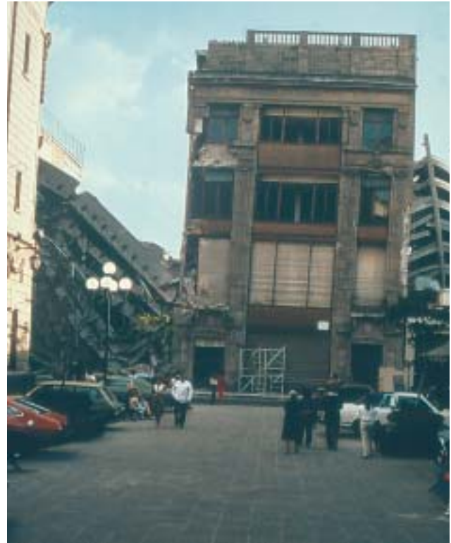
20/3 Das moderne Stahlbetongebäude links wurde durch den Zusammenprall mit dem älteren sehr steifen Gebäude rechts zum Einsturz gebracht (Mexico 1985).
