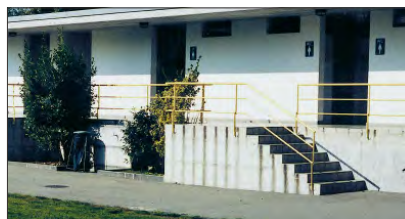
Construction sur murs
