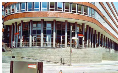
Construction sur piliers
