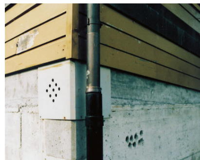
Evidement pour cylindre hydraulique
