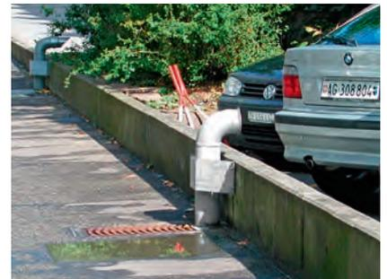
Surélévation de la prise d'air d'un abri.
