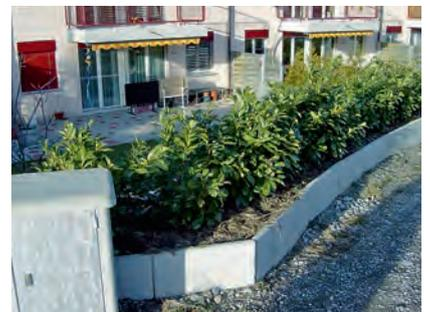
*Ce mur protège la cour vitrée située à un niveau inférieur contre l'afflux d'eaux superficielles par l'accès au bâtiment.*
