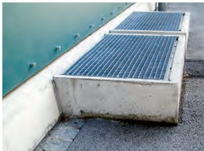
*Soupirail en position surélevée, éventuellement inséré dans l'aménagement local (banc).*
