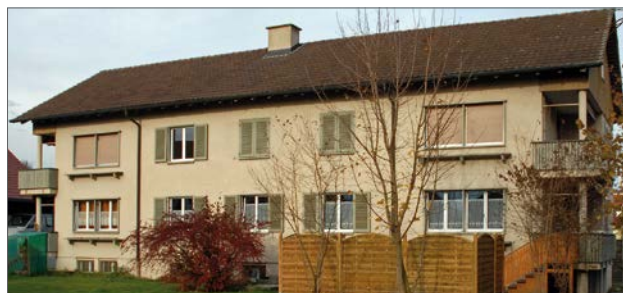
Bâtiment d'habitation de 1960 à Kriessern: la sécurité parasismique a été contrôlée par un ingénieur spécialisé dans le cadre de la planification de travaux d'assainissement. La sécurité parasismique a été jugée suffisante.
