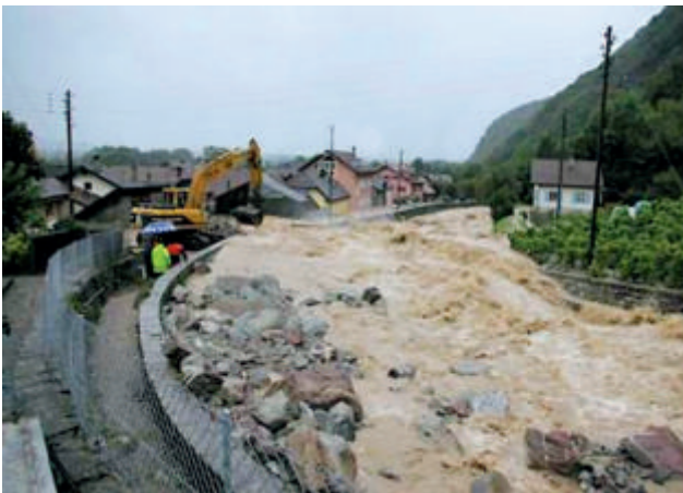
Figure 17: L'Eau Froide, charriant d'importantes quantités de matériaux, est sortie de son lit en amont du village de Roche (photo: SSCM).
