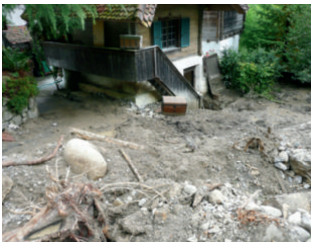
Figure 10: dommages par les alluvions et l'inondation sur le cône de déjection du Ralliggrabe, à côté du château de Ralligen (photo: Kellerhals + Haefeli AG).
