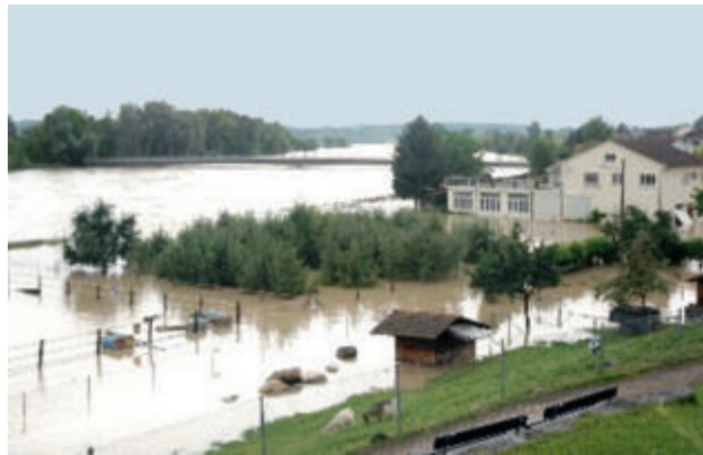
Figure 5: inondation par l'Aar à Döttingen (Austrasse) (photo: corps de sapeurs-pompiers de Döttingen-Klingnau)
