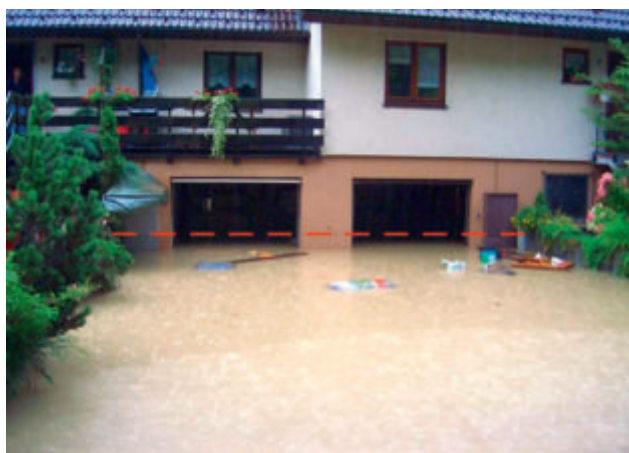
Figure 15: inondation du quartier de Wässerig à Obergösigen; la ligne hachée rouge indique le plus haut niveau atteint (photo: J. Merz, Obergösigen).
