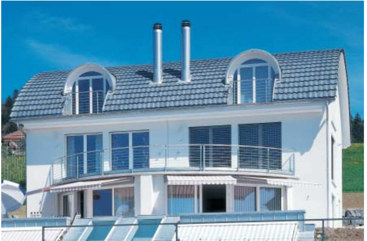
Tonnendach mit schiefergrauen Flachziegeln
