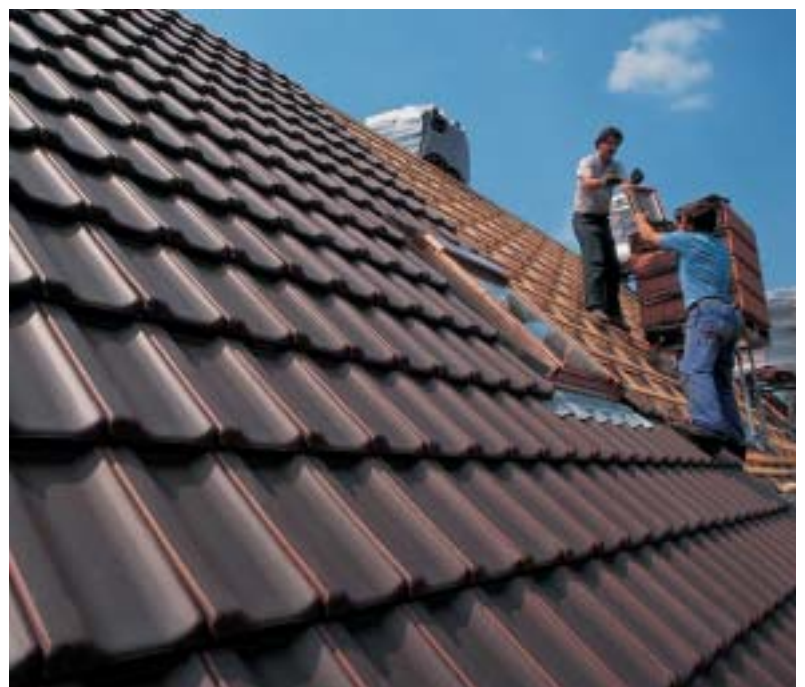
Die handwerkliche Arbeit ist entscheidend für die Qualität von Dachkonstruktion und Deckung
