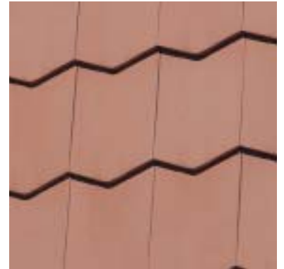
Biberschwanzziegel Einfachdach Lattweite: ca. 22 – 23 cm Deckbreite: ca. 17 cm Ziegelbedarf: ca. 25 Stk./m 2
