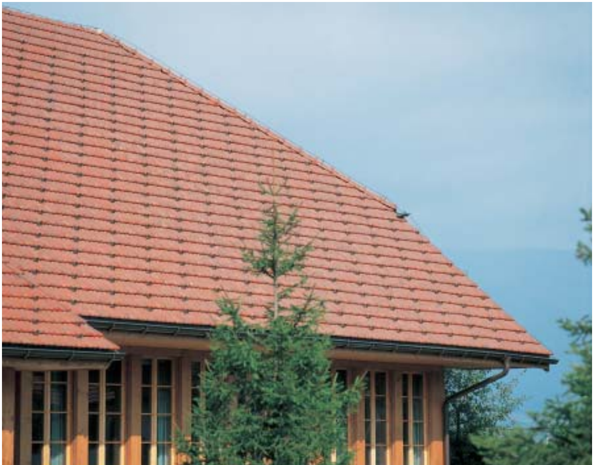
Krüppelwalmdach mit Schneehaltern, gedeckt mit Muldenziegeln «antik»
