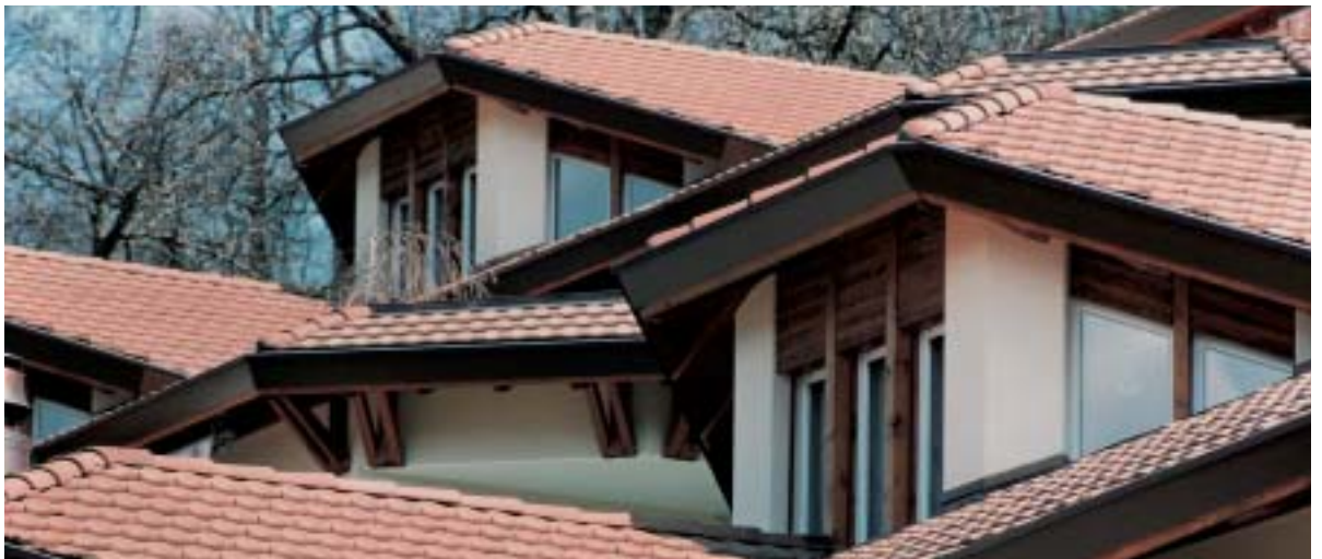
Aufgelöste Dachfläche mit hellbraunen Flachziegeln
