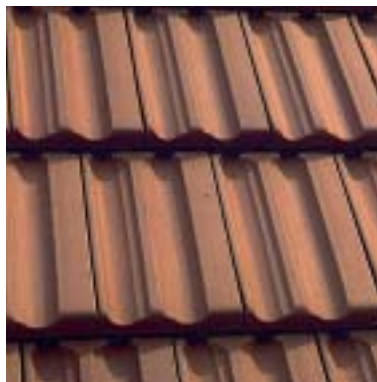
Muldenziegel Lattweite: ca. 32 – 37 cm Deckbreite: ca. 21 – 22 cm Ziegelbedarf: ca. 13 Stk./m 2
