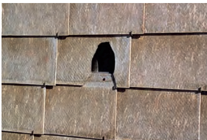
Perforation de plaques en fibres-ciment.
