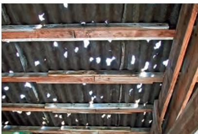
Perforation de plaques profilées en fibres-ciment.
