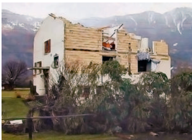
Toitures démantelées par des rafales de la tempête Lothar. Photo de gauche: Etablissement cantonal d'assurance de St-Gall; photo de droite: Assurance immobilière Berne
