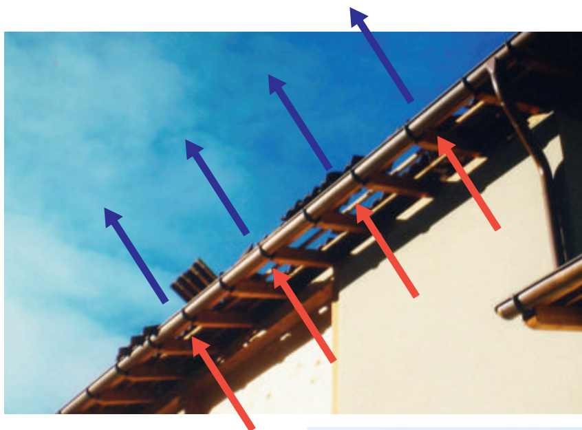
Les matériaux de couverture (p. ex. tuiles) des avant-toits sans lambrissage ne résistent pas aux sollicitations de succion générées par un vent même faible. Photos: Etablissement cantonal d'assurance des Grisons
