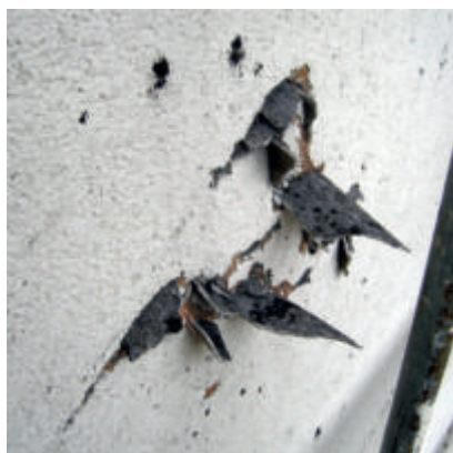
Gros plans de façades endommagées. Dans la photo de gauche, des fragments de plaques profilées en fibres-ciment arrachés par le
