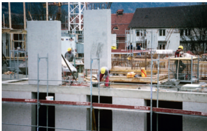
Les éléments massifs composant la structure porteuse sont bien visibles pendant la construction d'un bâtiment. Photo: M. Weidmann.
