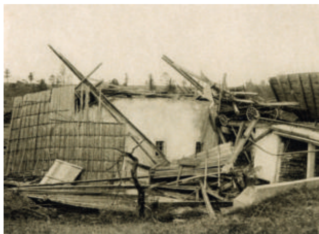
Toiture détruite par une tornade (12 juillet 1926, ferme «Geiser» au nord-est de La Chaux-de-Fonds; voir aussi page 58). Photo: Arts graphiques Haefeli & Co., La Chaux-de-Fonds (carte postale)
