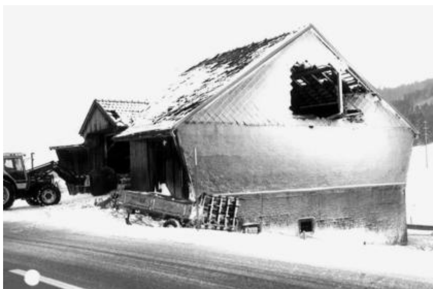
Etable dont le toit et la façade ont été sérieusement endommagés par Lothar en 1999. Photo: Etablissement cantonal d'assurance des bâtiments, Fribourg
