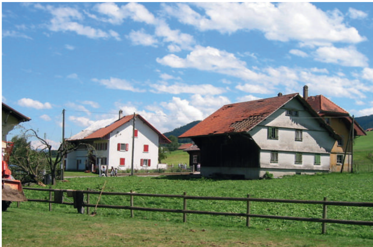
Bâtiments endommagés par une tornade en 2004. Photo: Etablissement cantonal d'assurance des bâtiments, Fribourg
