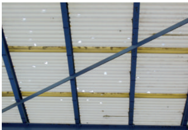
Figure 6.17: Panneaux de toiture en plastique, photo GVZ.
