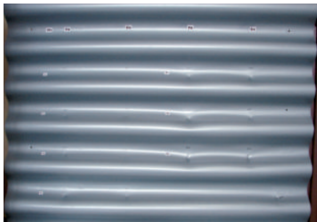
Figure 6.8: Tôle ondulée en aluminium, photo Empa.
