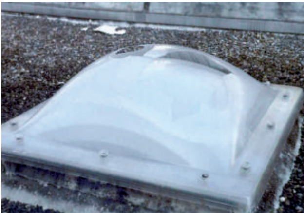
Figure 6.15: Coupole à deux couches, photo ECAB.
