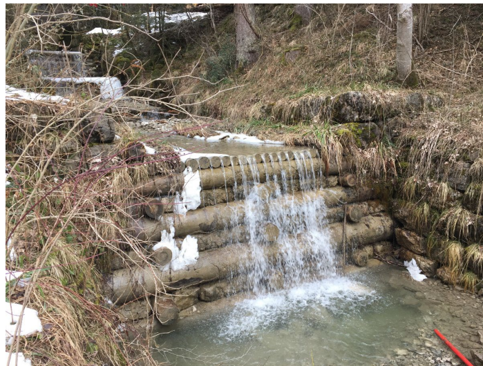
Aménagement de torrent en bois
