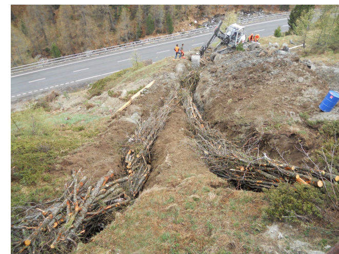
Drainage de versant au moyen de fascines de bois mort
