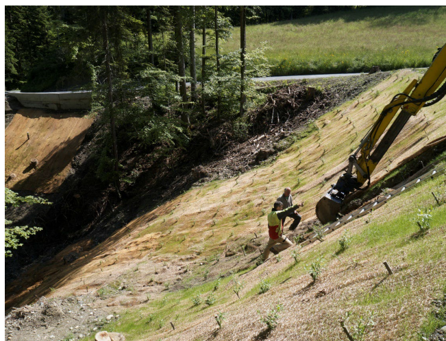
Protection contre l'érosion au moyen de nattes en laine de bois, d'ensemencement et de boutures
